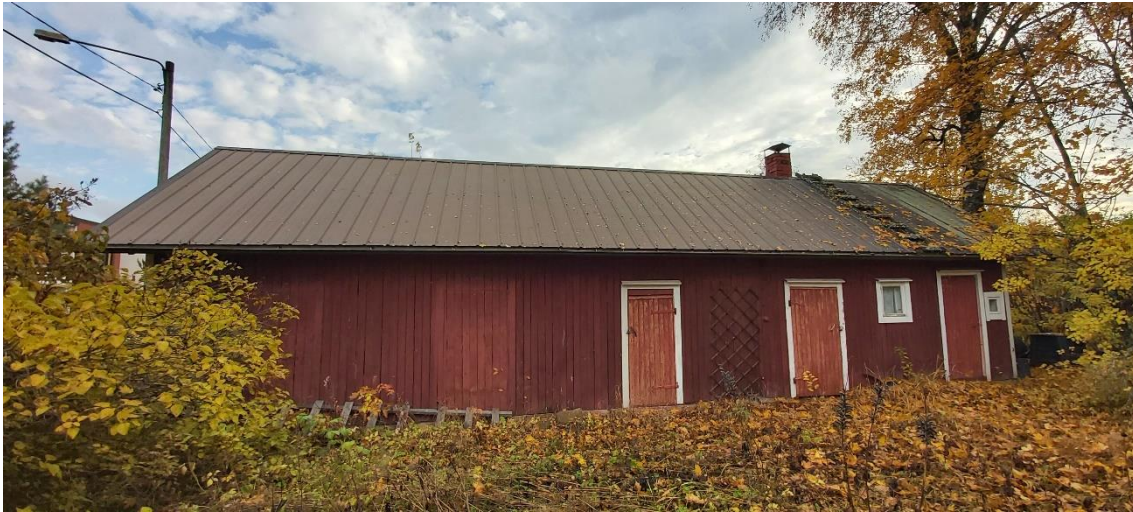
Kuva 103 Piharakennuksen julkisivu länteen pihan suuntaan. Rakennus rajaa kiinteistöä sen itälaidalla muodostaen suojaisaa pihapiiriä. Haastattelutiedon mukaan rakennuksessa on saatettu pitää hevosta.
