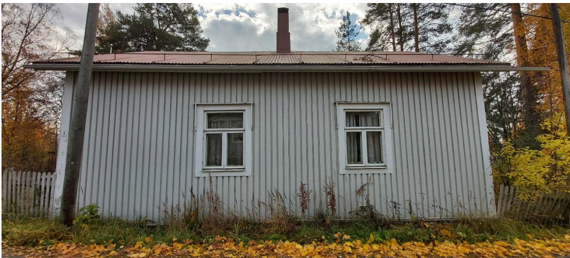
Kuva 100 Rakennuksen pääjulkisivu pohjoiseen Suojatein suuntaan.
