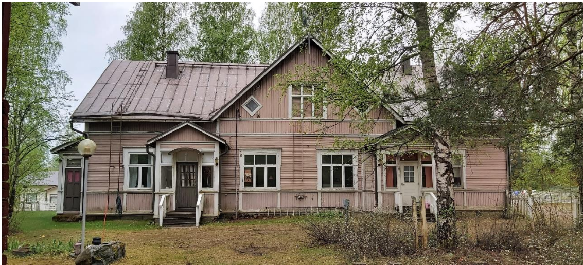
Kuva 13 Rakennuksen julkisivu sisäänkäynteineen itään päin sisäpihan suuntaan.
