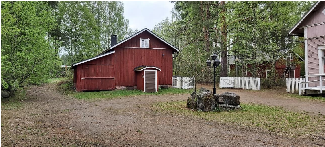
Kuva 18 Kiinteistöllä olevat talousrakennukset ovat julkisivuväriältään punamullattuja. Etualalla pohjoisen talousrakennuksen julkisivu länteen.
