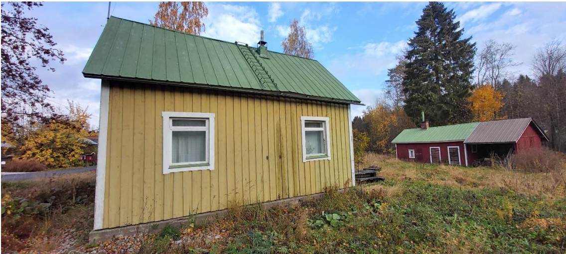
Kuva 105 Päärakennuksen julkisivu etelään ja talousrakennuksen julkisivu länteen Suojatien suuntaan.
