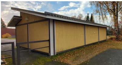
Kuva 5 Kiinteitöllä ijitsevaa talousrakennusta (1961) pohjoiseen ja itään.
