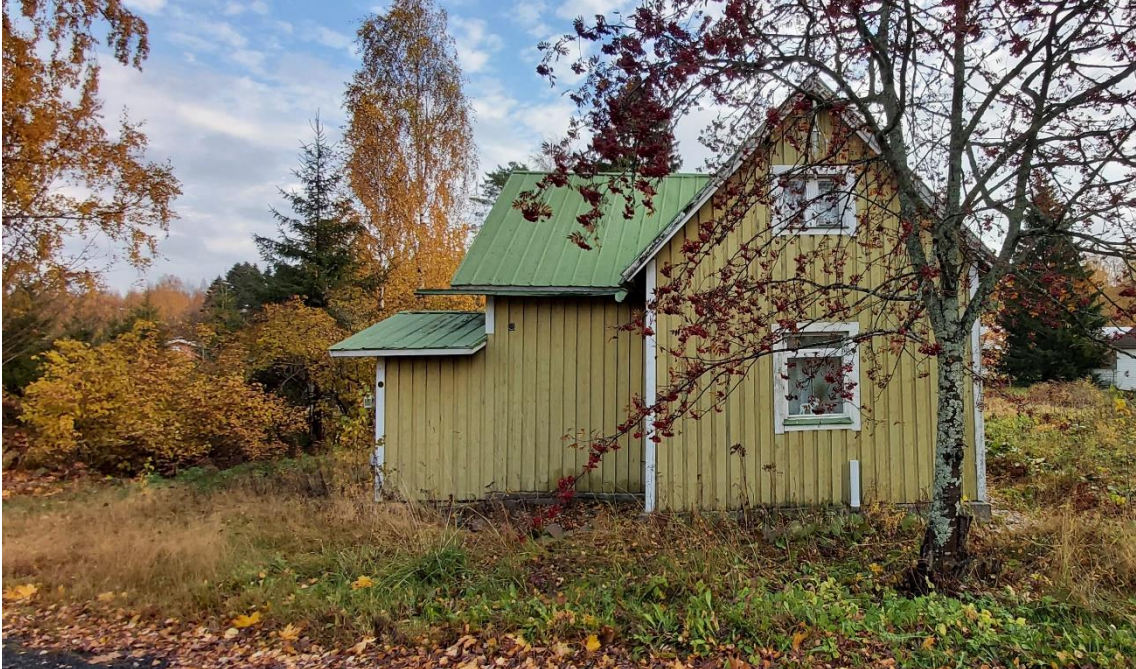
Kuva 104 Rakennuksen pääjulkisivu länteen Suojatien suuntaan.
