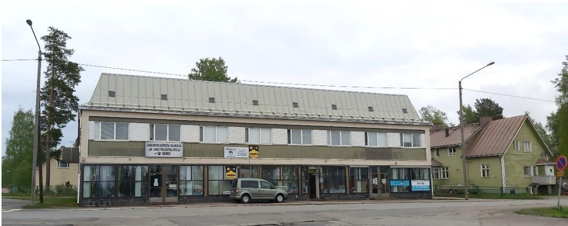
Kuva 9 Entisen Säästöpankin pääjulkisivu länteen Keskustien suuntaan.
