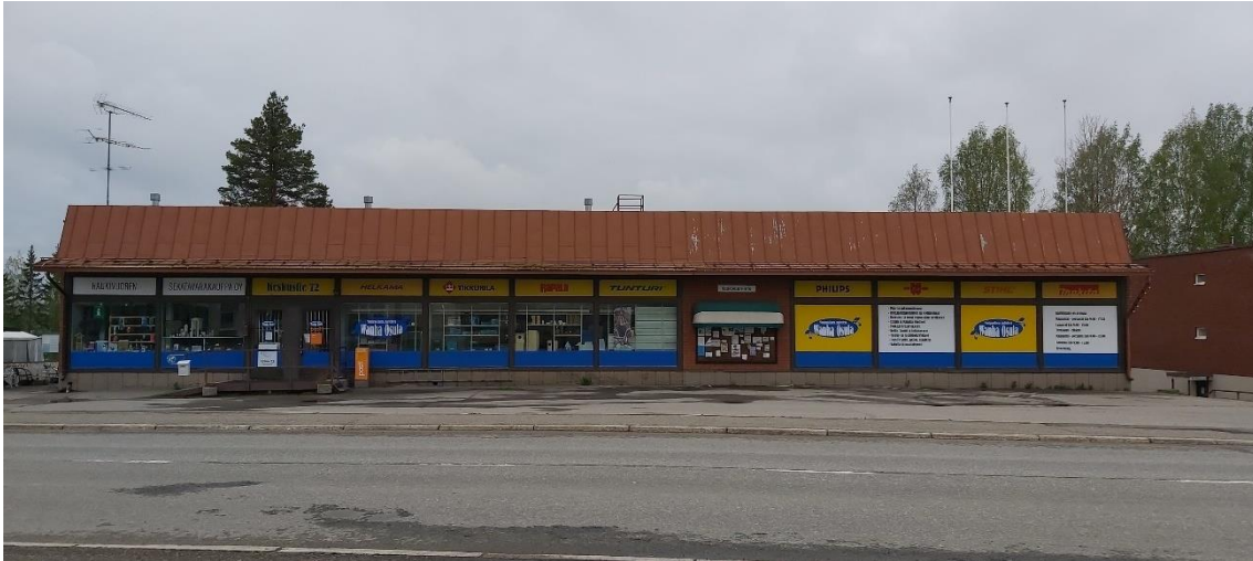
Kuva 61 Wanhan Osulan pääjulkisivu itään Keskustien suuntaan.
