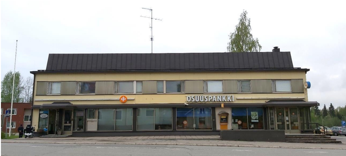
Kuva 3 Osuuskassan liiketalon pääjulkisivu itään Keskustien suuntaan.
