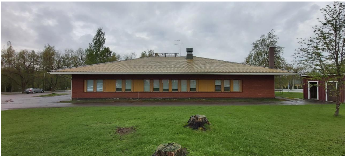
Kuva 47 Rakennuksen julkisivu itään.
