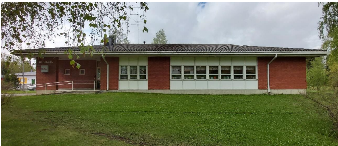
Kuva 28 Kirjaston julkisivu itään Keskustien suuntaan.
