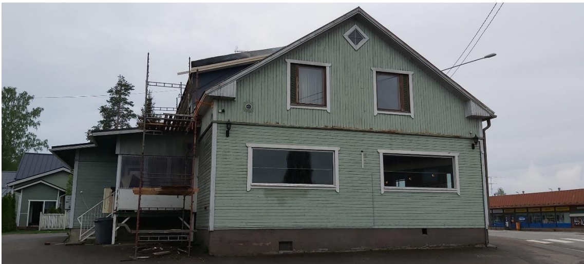
Kuva 54 Rakennuksen päätyjulkisivua pohjoiseen Haukivuorentien suuntaan.
