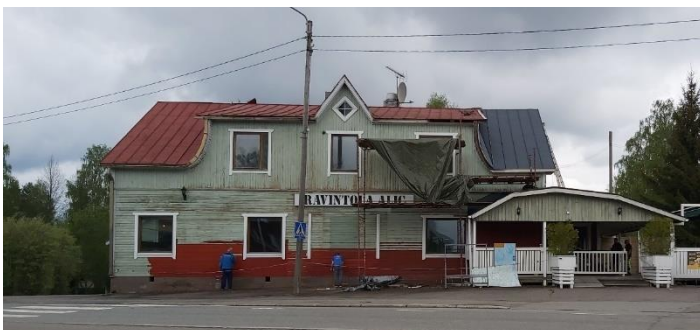
Kuva 59 Rakennuksen kunnostusta, julkisivut ja vesikatto uudistetaan.
