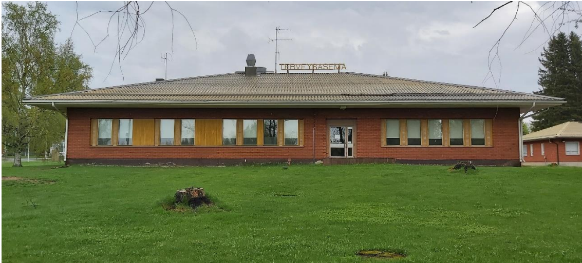
Kuva 46 Entisen terveysaseman pääjulkisivu länteen Keskustien suuntaan.
