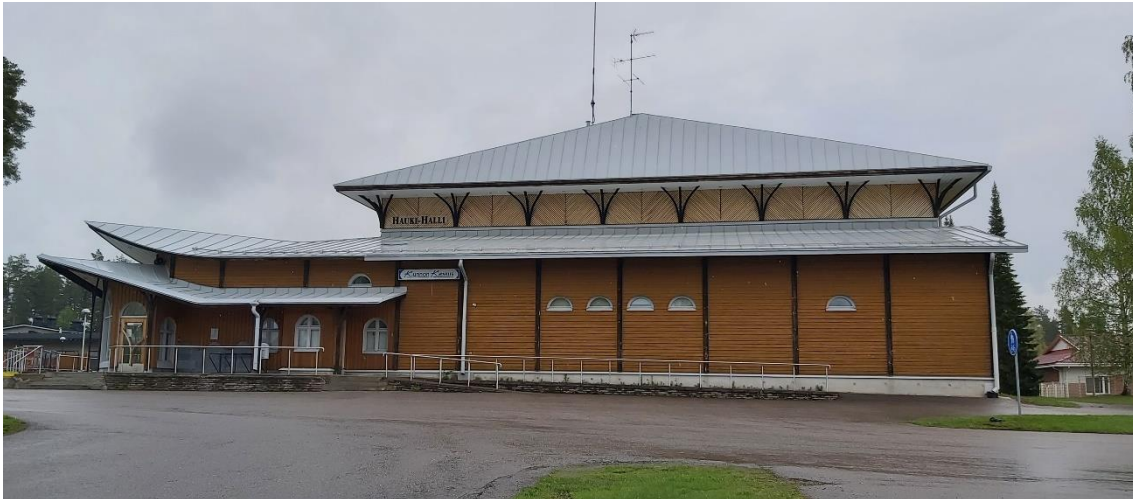
Kuva 41 Hauki-Hallin julkisivu länteen Keskustien suuntaan.
