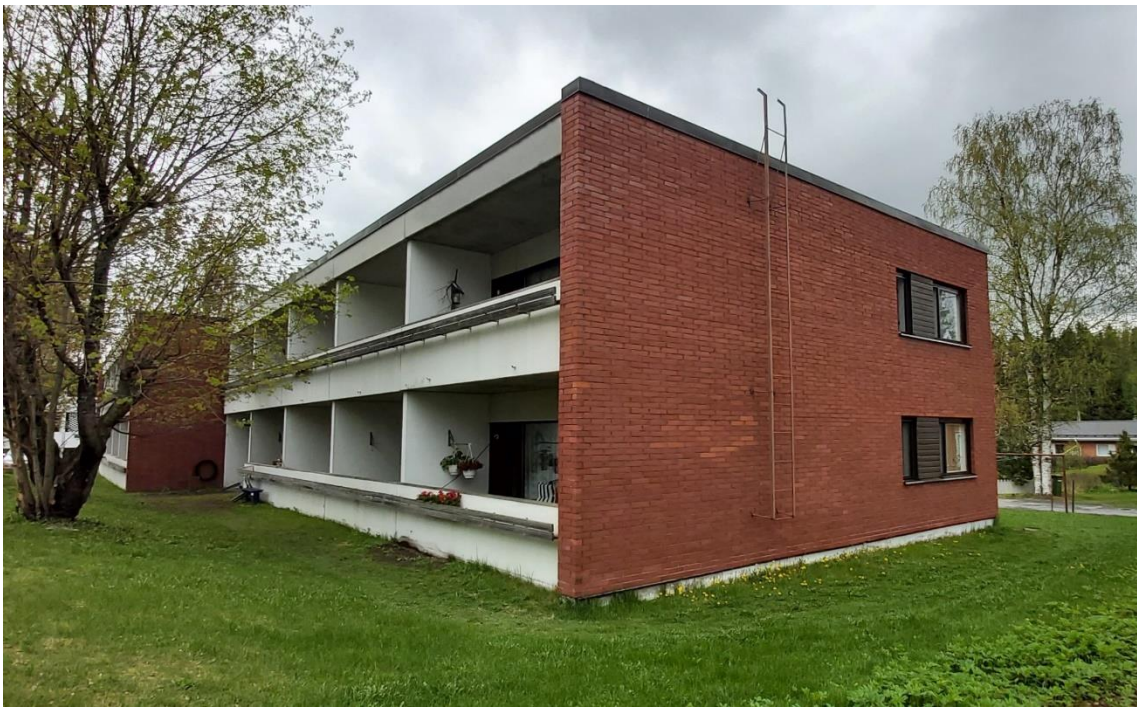
Kuva 89 Rakennuksen eteläinen pääty sekä länteen avautuvat nauhaparvekkeet.
