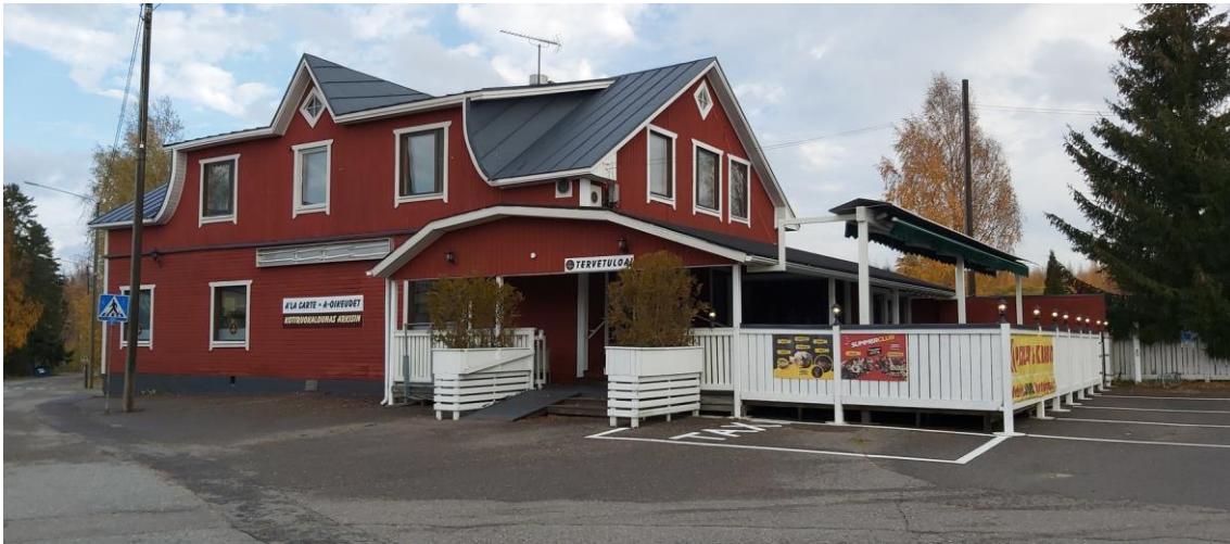
Kuva 60 Rakennus kunnostutöiden jälkeen uudessa julkisivuvärytyksessään.
