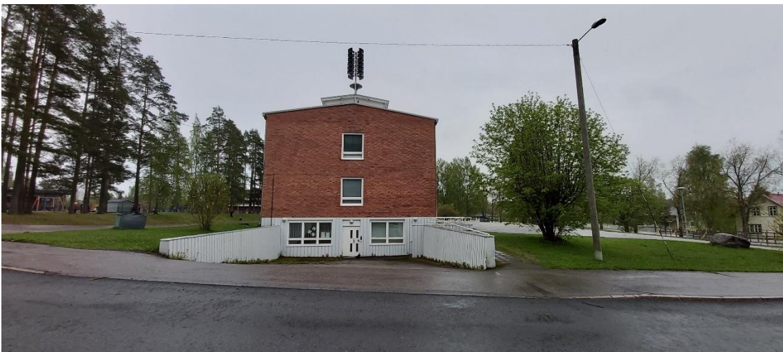
Kuva 38 Haukivuori-talon, entisen haukivuoren kunnantalon päätyjulkisivu pohjoiseen torin suuntaan.
