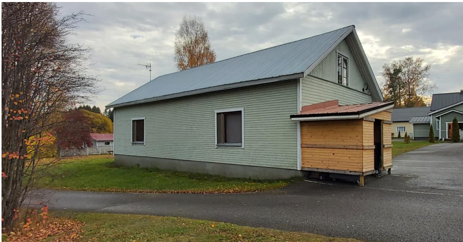
Kuva 58 Talousrakennuksen julkisivua pohjoiseen ja länteen.
